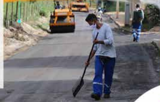
ASFALTAMENTO NA TAQUARA
