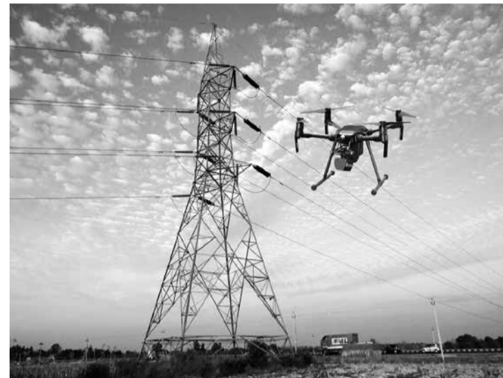
Sistema desenvolvido pela Cemig irá inspecionar linhas de distribuição e transmissão por meio de VANTs e pode beneficiar outras empresas do setor elétrico.
