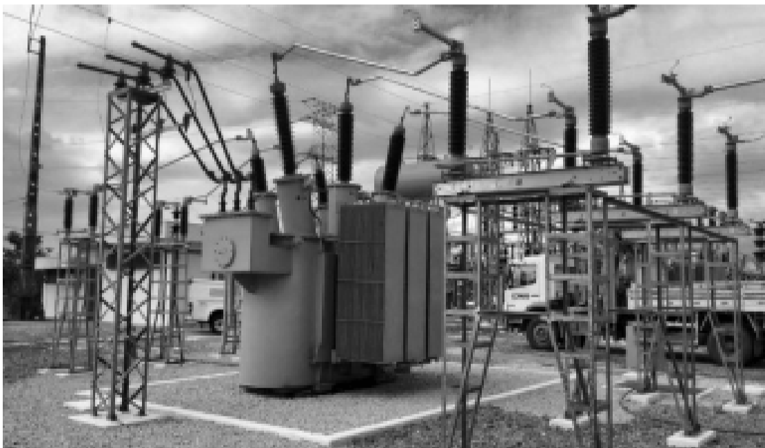
Novo transformador instalado na subestação de Teófilo Otoni
