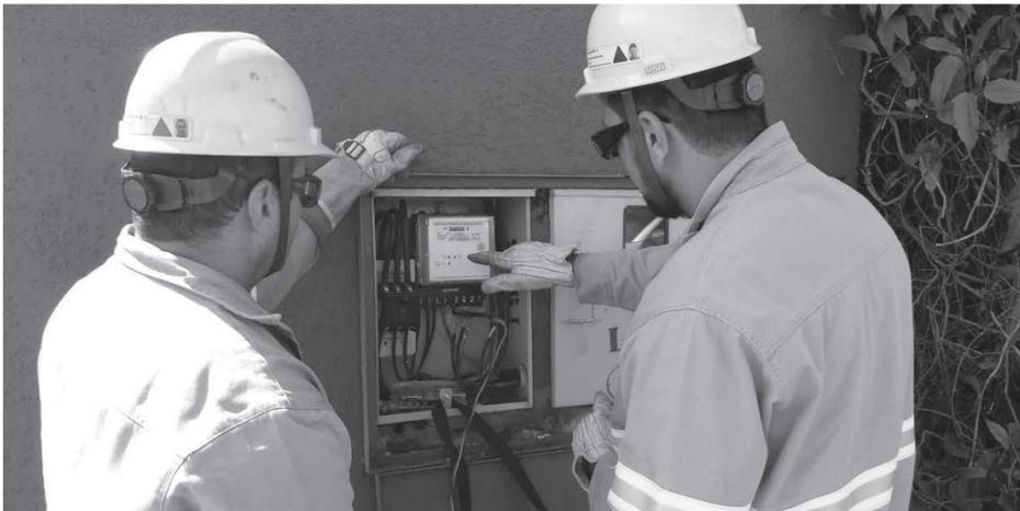
Eletricistas da Cemig realizam inspeção em medidor de energia
