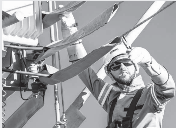
Técnico da Cemig realiza manutenção na rede elétrica - Elderth Theza/Cemig Divulgação
