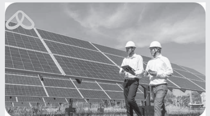
O programa consiste em criar parques de geração de energia elétrica através de conglomerados de placas fotovoltaicas
