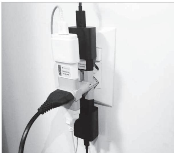
A prática do uso de “Ts” e “benjamins” é perigosa e não recomendada, já que pode provocar sobrecarga de energia e curtos-circuitos em redes não preparadas para suportar a carga elétrica demandada, causando incêndios e até acidentes fatais
