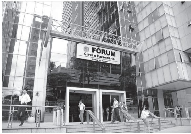
Fórum Raja vai abrigar Vara Agrária e de Acidente de Trabalho e a Contadoria e Tesouraria durante obras no Fórum Lafayette
