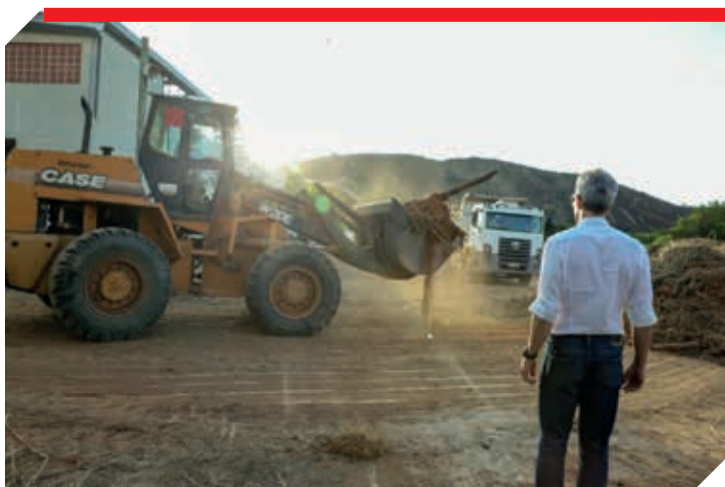
Zema acompanhando os trabalhos no local onde daqui a 2 anos estará entregando o hospital pronto
