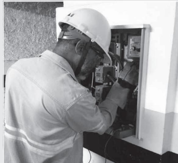
*O padrão de energia deve ter o acesso livre o tempo todo, pois a qualquer momento equipes da Cemig podem precisar acessar a instalação para procedimentos de inspeção, manutenção, leitura e outros serviços*
