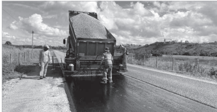
Obra de pavimentação da MGC-418, no município de Nanuque, também conhecida como Rodovia do Boi
