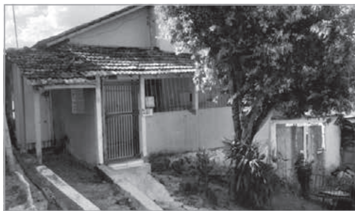
Imóvel localizado na rua Nova Lima, 230, bairro Laticínios
