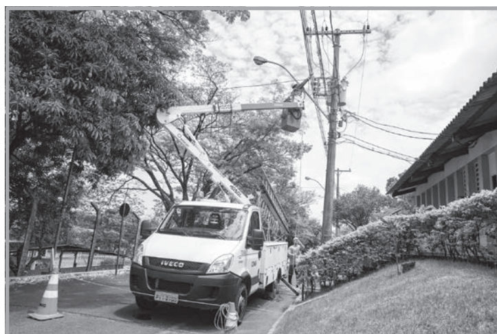
Até o final deste ano, a companhia vai realizar mais de 835 mil podas de árvores e providenciar a limpeza de mais de 50 mil km de linhas, bem como vistoriar, por meio de drones e equipamentos de termovisão, centenas de km da rede de média tensão
