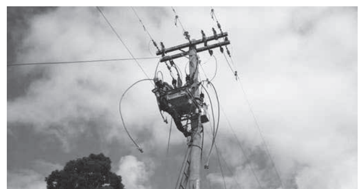
Equipe da Cemig instala religador na rede elétrica
