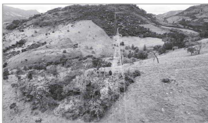
A nova Linha de Distribuição (LD) Carangola - Padre Fialho 138 kV, que garantirá dupla alimentação para o sistema elétrico de alta tensão que atende 13 cidades da área de concessão da companhia, vai beneficiar diretamente cerca de 75 mil clientes. Outros 200 mil clientes de 25 cidades da região também serão beneficiados indiretamente, com o reforço do sistema, pela entrada em operação do empreendimento
