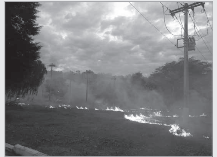
A tecnologia do Sistema de Monitoramento e Alerta de Queimadas (SMAQ) da companhia, que identifica focos de calor a até 1,5 km das linhas de distribuição e transmissão, permite que as equipes de campo sejam acionadas com agilidade, muitas vezes antes de o fogo atingir as estruturas da rede elétrica
