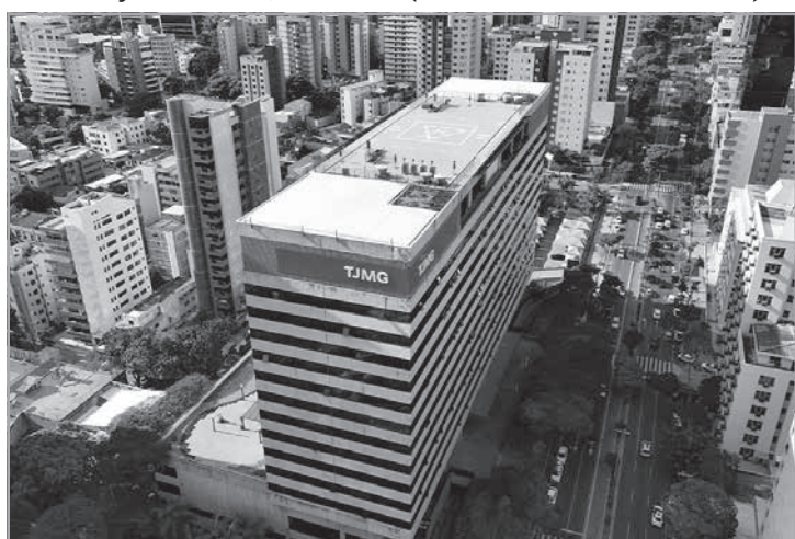
O heliponto do Edifício-Sede do TJMG é homologado na Agência Nacional de Aviação Civil e seu plano de zona de proteção foi aprovado pelo Comando da Aeronáutica (Crédito: Juarez Rodrigues / TJMG)
