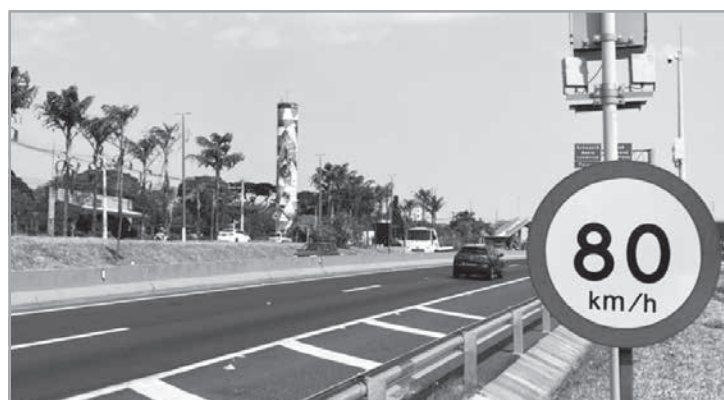
Equipamentos de velocidade média já foram instalados nas BRs 040 e 050 pelas concessionárias (Foto: Divulgação)
