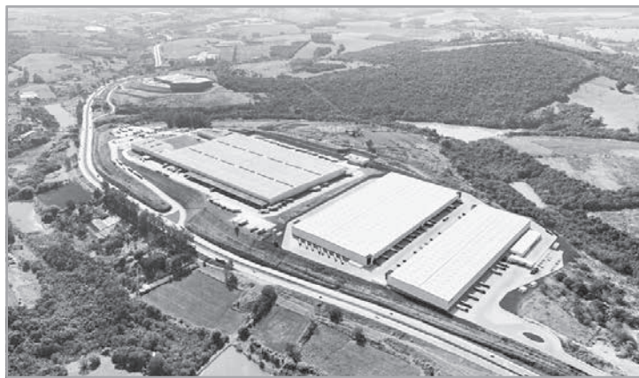
Além da entrega da Fase I, o projeto já avança para sua expansão. A Fase II conta com projeto aprovado, terraplanagem em andamento e potencial para a construção de mais 50 mil metros quadrados (Foto: Ascom/PMPA)
