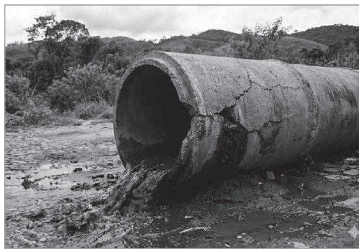
Problema com refluxo da rede de esgoto gerou transbordamento em parte de residência em Matozinhos (Crédito: Google Gemini / Imagem ilustrativa)
