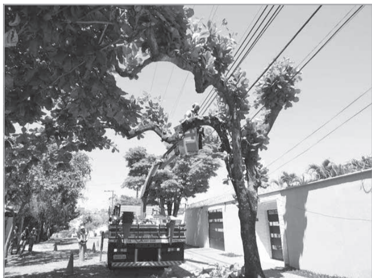
No programa de manutenção preventiva, a Cemig planeja realizar mais de 900 mil podas de árvores e a limpeza de faixa de mais de 50 mil quilômetros de linhas, e vistoriar, por meio de drones e equipamentos de termovisão, trechos da rede de média e alta tensão. A companhia também vai substituir milhares de equipamentos, como cruzetas, postes, isoladores e pára-raios
