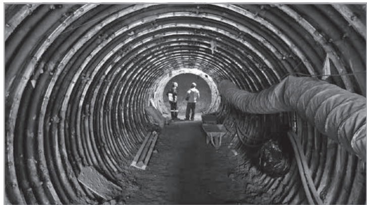
Entre as obras destacadas no balanço do semestre está a ampliação do Sistema Rio Manso, que tem conclusão prevista para o primeiro semestre de 2027 e prevê, ao todo, 12 quilômetros de adutoras de água tratada entre Mário Campos, Sarzedo e Betim, com investimento total de cerca de R$ 400 milhões. Crédito: Divulgação/Copasa
