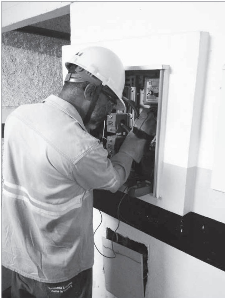
O medidor de energia pertence à Cemig e sua manutenção é realizada exclusivamente pela companhia. Já a caixa de medição, o padrão de entrada, eletrodutos, cabos internos e demais componentes instalados após o ponto de entrega devem ser mantidos pelo proprietário do imóvel
